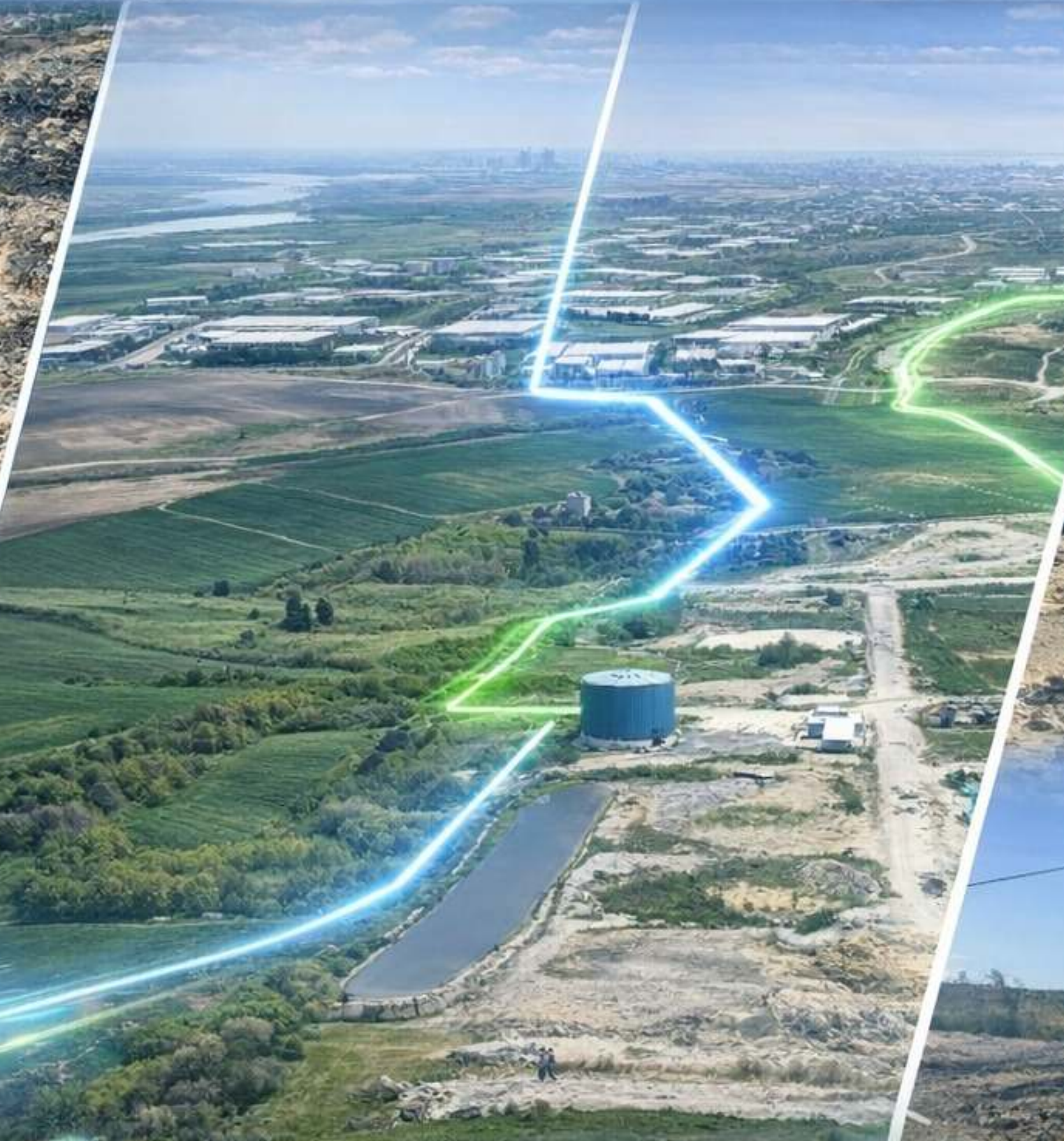
TEMİZ SU ve ATIK SU BAĞLANTI ÇALIŞMALARI 10.000 m 3 su deposu ve hatlar tamamlandı
