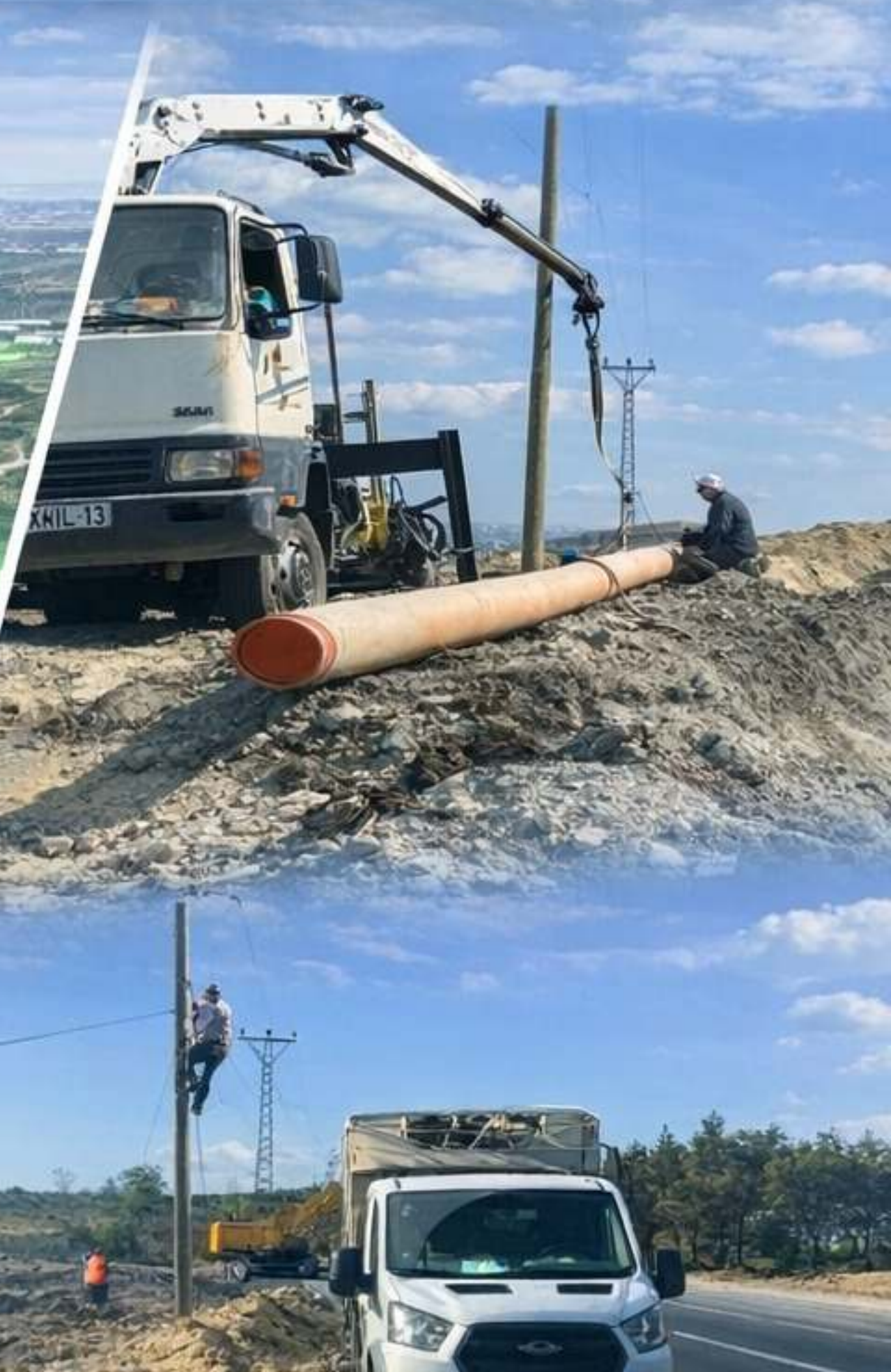
FİBER OPTİK KABLO DÖŞEMEŞİ Çelik boru ile güvenli gaz hattı oluşturulması
