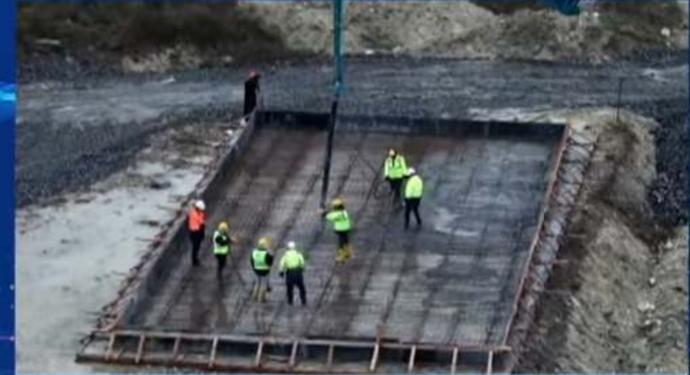
Kuzey Paslanmaz Fabrika Temel Atımı
