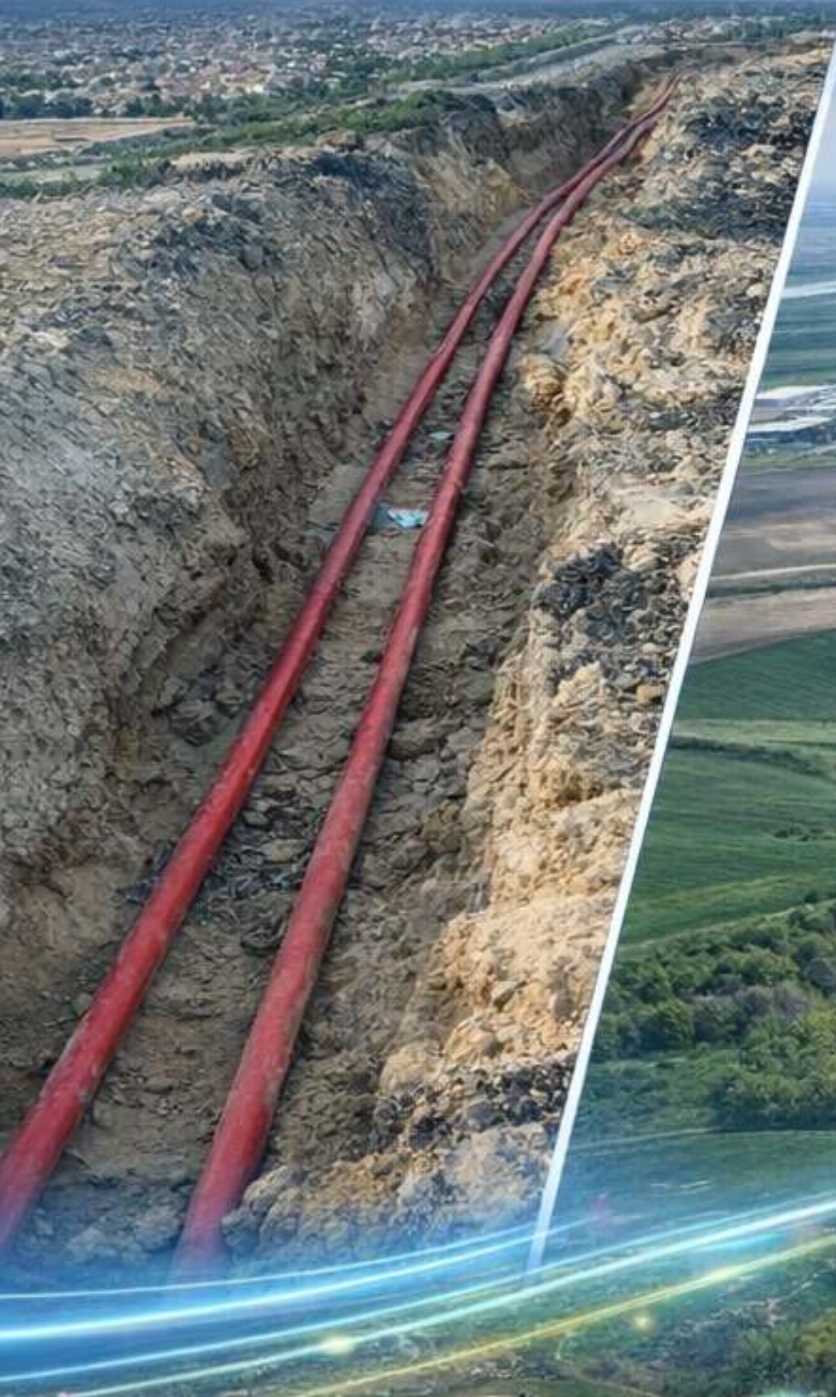
YERALTIDAN YÜKSEK GERİLİM HATTI DÖŞEMESİ (126 KV, 147.600 m uzunluk)
