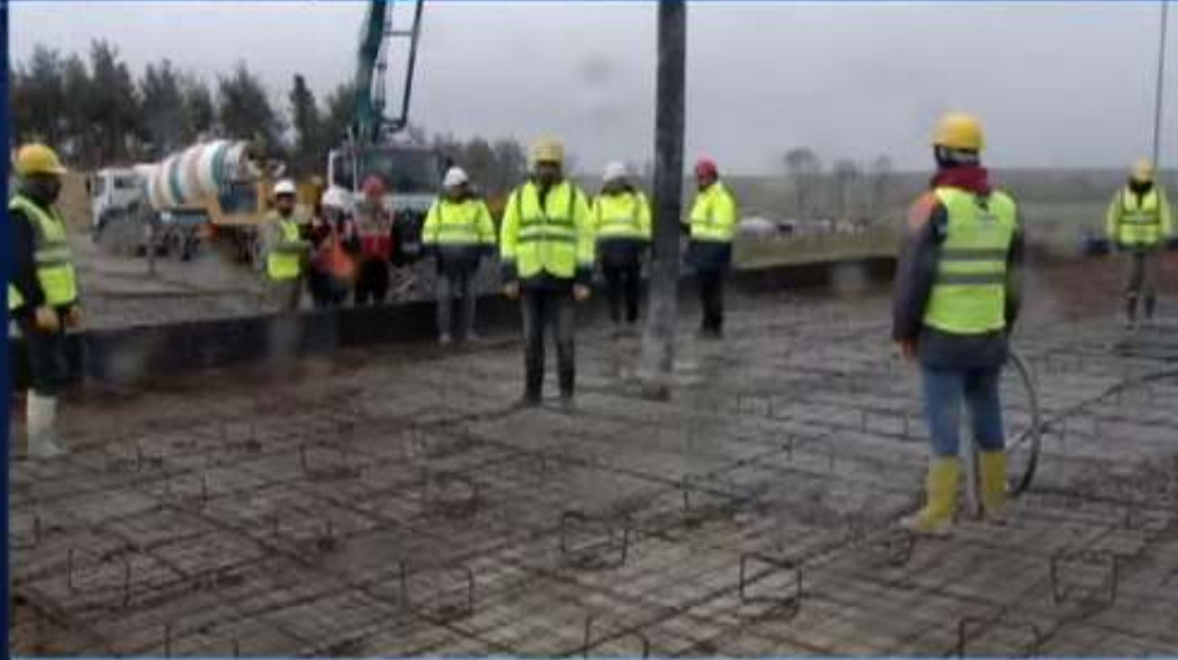
Nedim Kisbu Camii Temel Atımı
